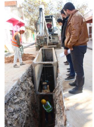
Travaux de réseaux d'assainissement
