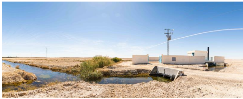
Station de traitement des eaux en construction
